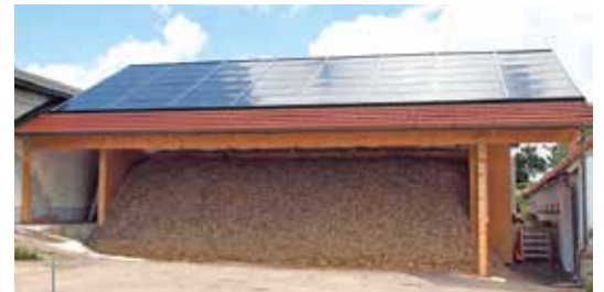
Solare Trocknungsanlage beim Sägewerk Weingartner (96m 2 Solarluftkollektoren).
