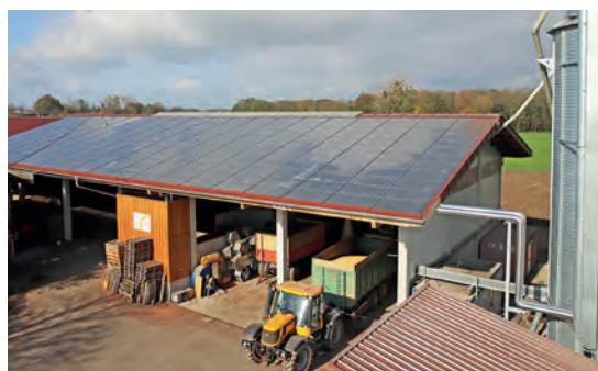
Die 500-Quadratmeter-Luftsolaranlage ist das Herzstück der preisgekrönten Trocknungsanlage.
